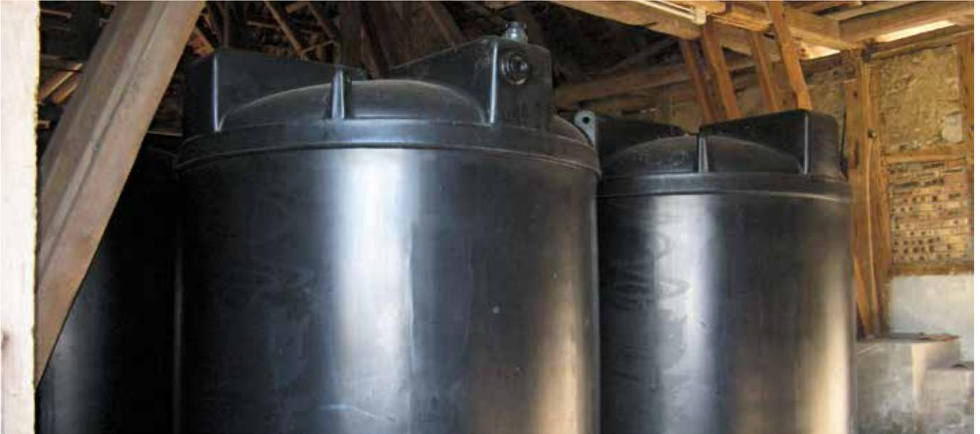
Keine Angst, die Lagertanks halten mehr aus als Sie denken. Aber vergessen Sie nicht die Tragkraft des Bodens zu prüfen!
